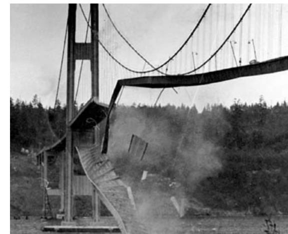
Most se během hodiny hroutí. Příčinami vyjádřenými matematicky se zabývají vědci z plzeňské univerzity
