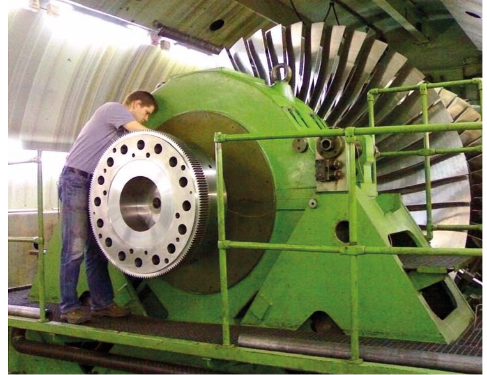
Jindřich Liška nastavuje snímače pro měření vibrací turbíny v atomové elektrárně
